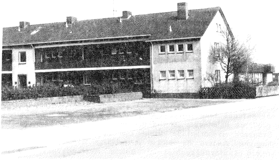
Abb. 7 Alter Postweg Gronau/Westf.: Städtische Obdachlosenwohnungen (zwei Zeilen) in Industrie-/Gewerbegebiet
